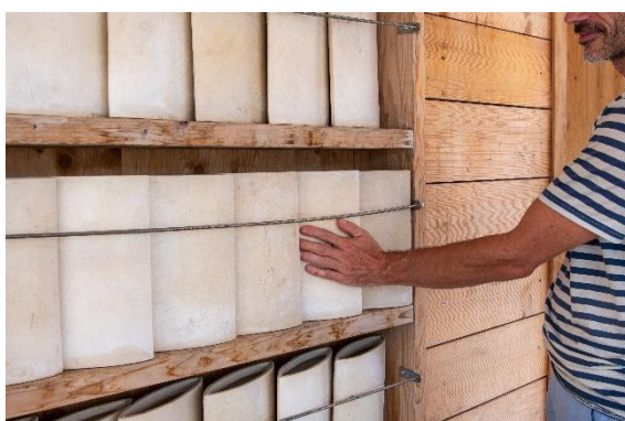
Figure 1 Modules de rafraîchissement du pavillon de haut en bas et de gauche à droite : végétalisation ; brumisation, douche et ombrage ; paroi de céramiques poreuses ; réception de l'eau de la douche
