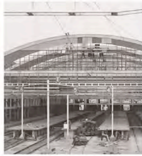
Halle aux marchandises durant la construction, env. 1952, source : CFF historic
